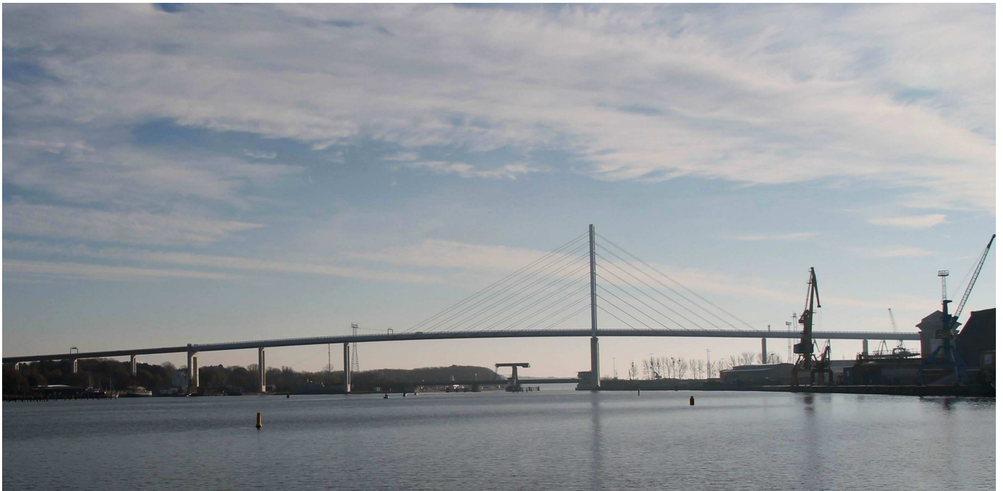
Rügenbrücke ( im Hintergrund Rügendammbücke )
