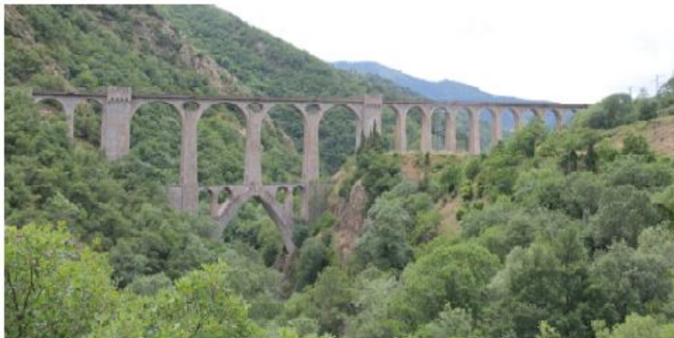
Cerdagne - Séjourné-Viadukt über Têt-Fluss bei Fontpédrouse in den französischen Vorpyrenäen - Strecke des "Le Train Jaune" abgebildet auf der Marke Mi 3479, Ausgabe 2000
