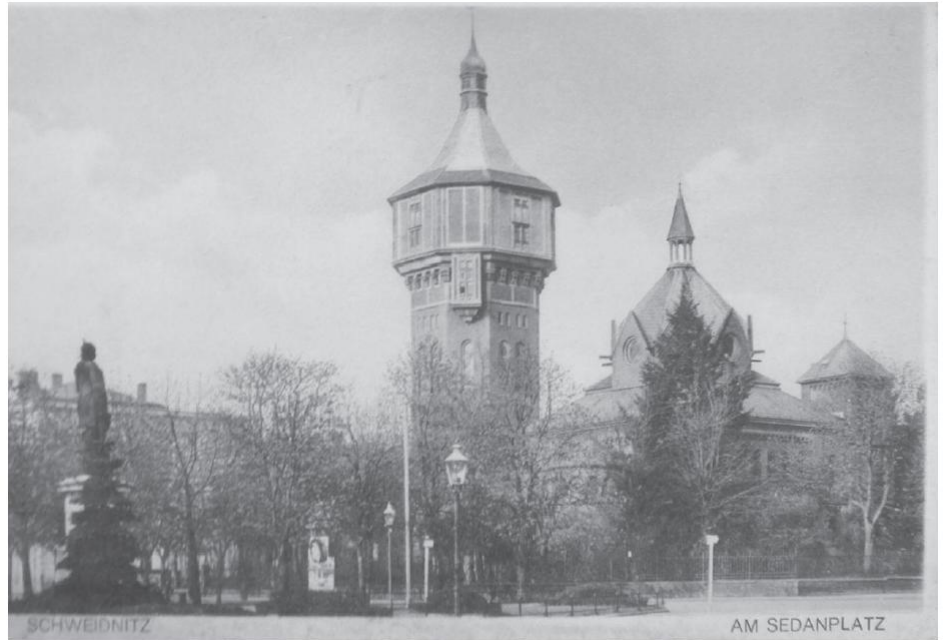
Synagoge (rechts) am Sedanplatz in Schweidnitz, versteckt hinter dem Wasserturm.
