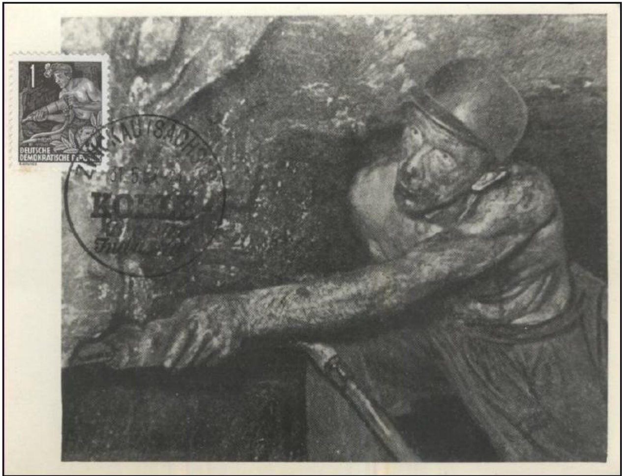
Ein Kumpel mit Abbauhammer am Flöz in der Zwickauer Steinkohle
