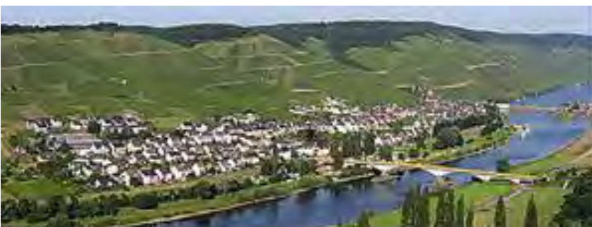
Vorne die Zeltinger Brücke und im Hintergrund Stauwehr und Schleuse
